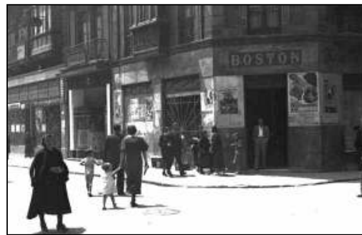
CALLE CORRIDA ESQUINA CON CALLE LANGREO, JUNIO DE 1937
